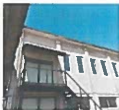
Închiriez spațiu zona Frigorifer etj 1
