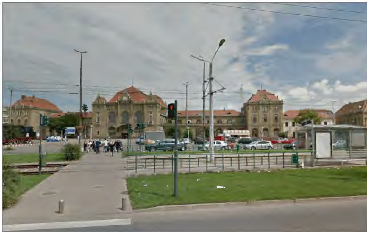
Figura 2.69. Zona intermodală. Piața Gării Arad.
