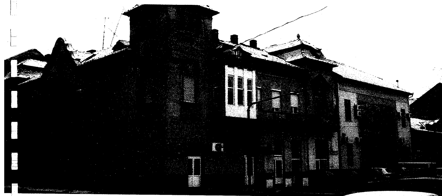
Fig.14: Reabilitarea parțială și incorectă a clădirilor istorice au un impact negativ asupra imaginii orașului
