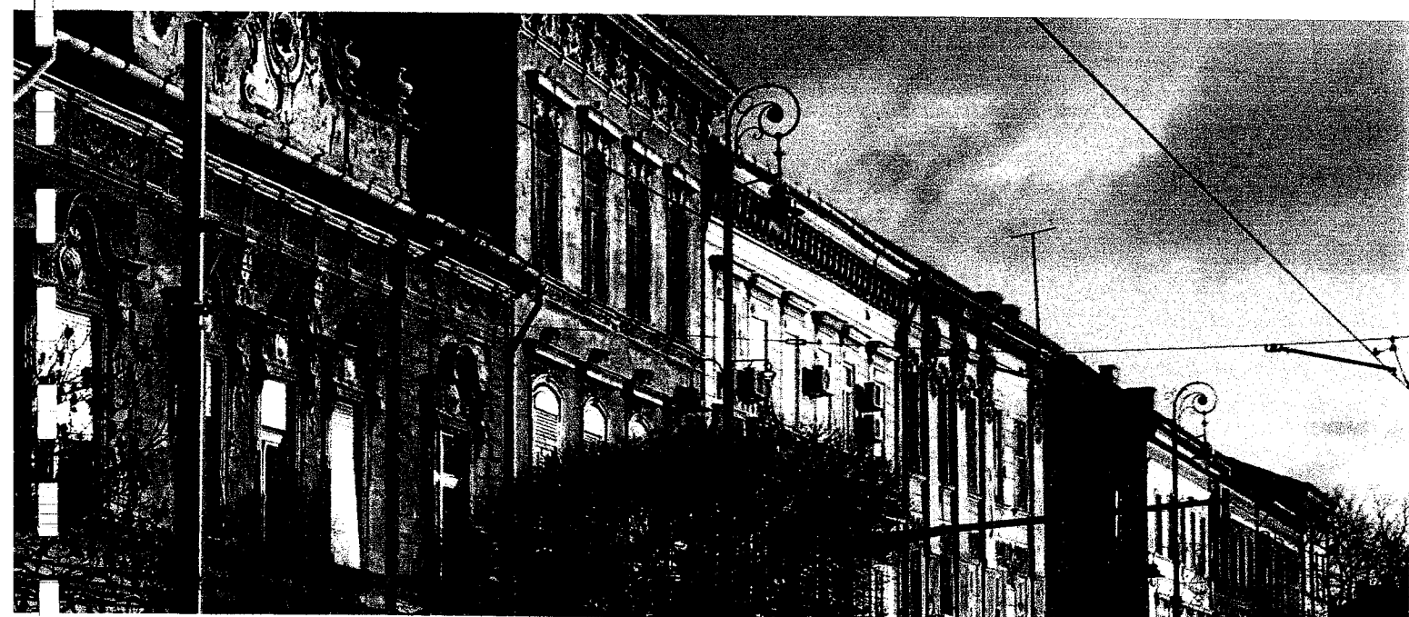
Fig.9: Ansamblul de case istorice cu valoare arhitecturală, istorică și turistică, în stare avansată de degradare
