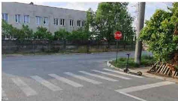
(a) Str. Digului cu Str. – trecere de pietoni cu marcaj, dar fără indicator
