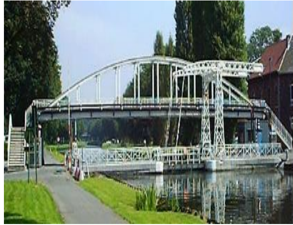
Pod peste canal la Bracquenes
