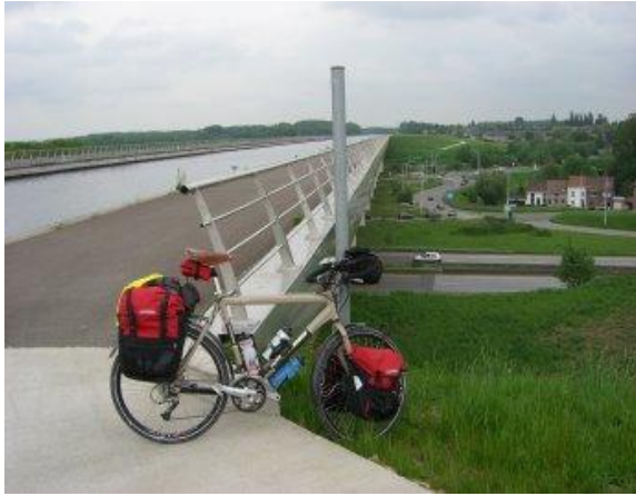
Canalul Central construit deasupra unei sosele
