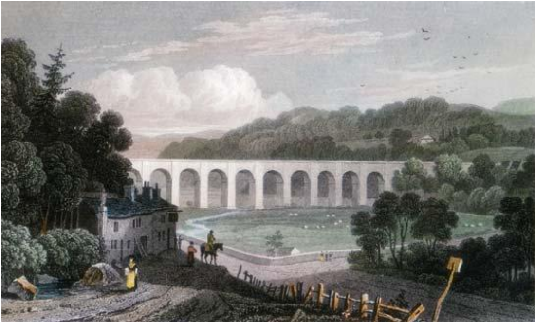
Apeductul navigabil Chirk pe canalul Ellesmere-1829
