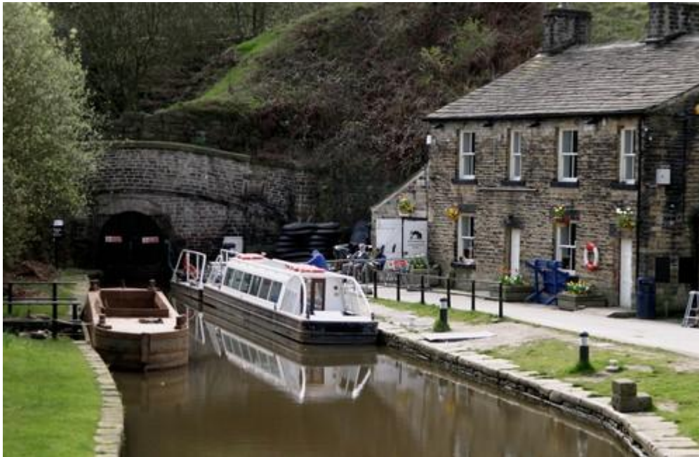
Tunelul Standedge-Intrarea in tunel
