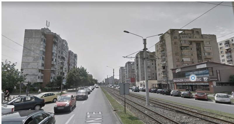
FIGURA 33 PEISAJ REZIDENȚIAL DE LOCUINȚE COLECTIVE, CALEA AUREL VLAICU
